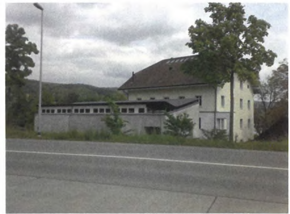
Wohn-,Gewerbegebäude, Richtung Aare
